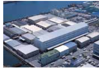
関西物流倉庫
